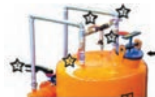
۲۰- شیرهای برگشت (By pass)، ۳ و ۴- شیرهای ورودی و خروجی مخزن ۵- شیر فلکه روی لوله اصلی
