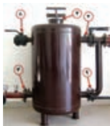
ب) تصویر واقعی شکل ۲۲- صافی شن
